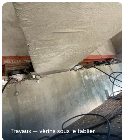
Contrôle des poutres réparées
